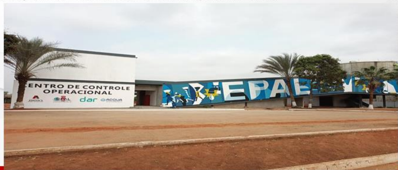
Avanço das Obras Civas do Centro de Controlo Operacional - Kikuxi
