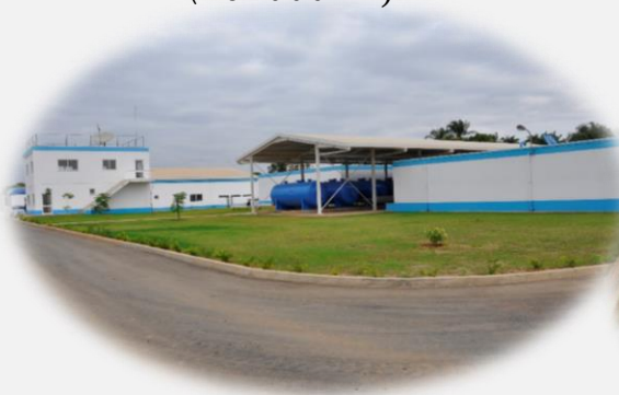
ETA Calumbo (51 840 m³/dia)
